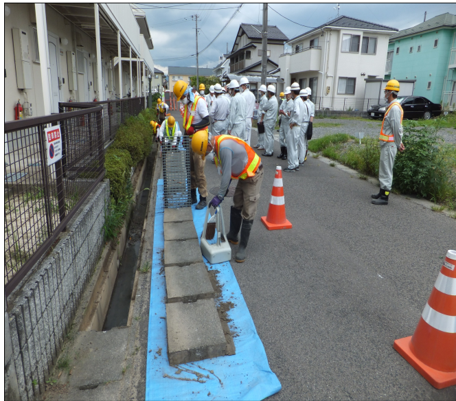
▲市内進む道路側溝の除染現場
